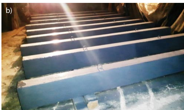
Rys. 6. Elementy pokryte powłoką: a) kręgi betonowe, b) belki żelbetowe (opracowanie własne)
