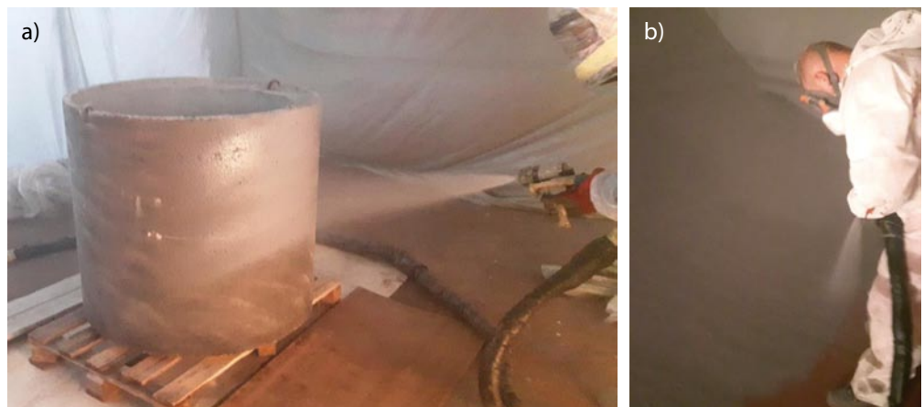
Rys. 4. Aplikacja polimocznika na podłoże: a) betonowe, b) stalowe (opracowanie własne)
