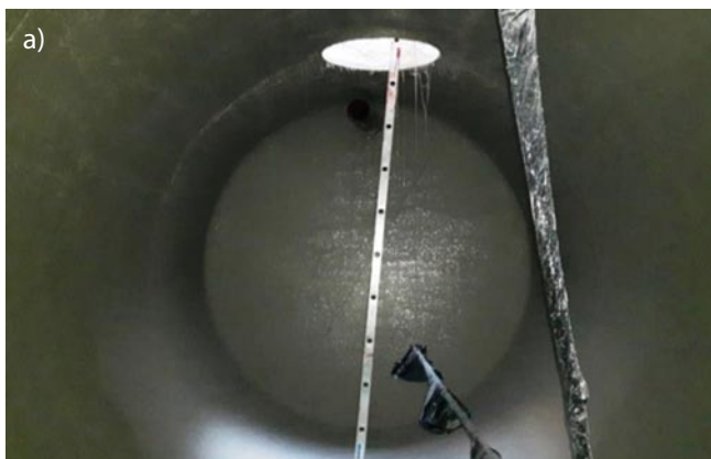
Rys. 5. Przykłady aplikacji powłoki w zbiornikach stalowych: a) zbiornik walcowy, b) zbiornik prostokątny (opracowanie własne)
