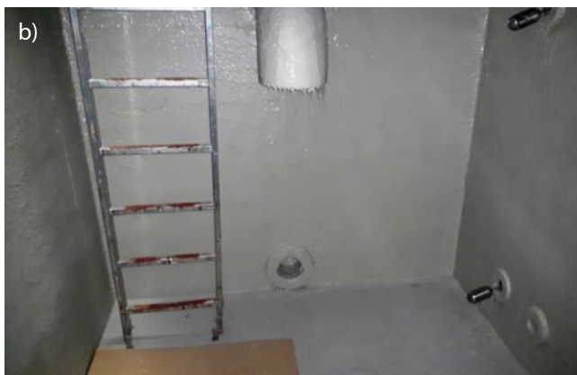
Rys. 5. Przykłady aplikacji powłoki w zbiornikach stalowych: a) zbiornik walcowy, b) zbiornik prostokątny (opracowanie własne)
