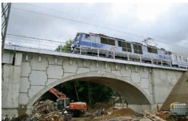
Ryc. 3. Wiadukt łukowy TechSpan® – strona zewnętrzna ze ścianami z gruntu zbrojonego TerraClass®
