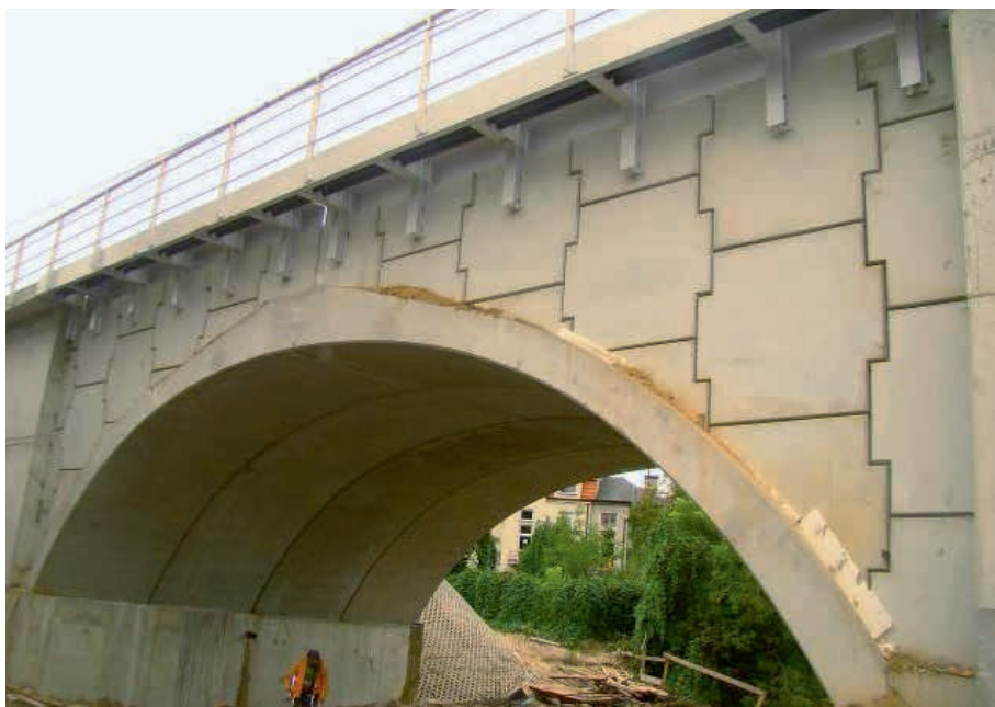
Ryc. 11. Prace wykończeniowe na wiadukcie kolejowym TechSpan® w Krakowie
