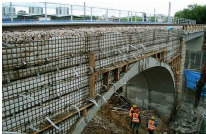
Ryc. 4. Wiadukt łukowy TechSpan® – strona wewnętrzna ze ścianami z gruntu zbrojonego TerraTrel®
