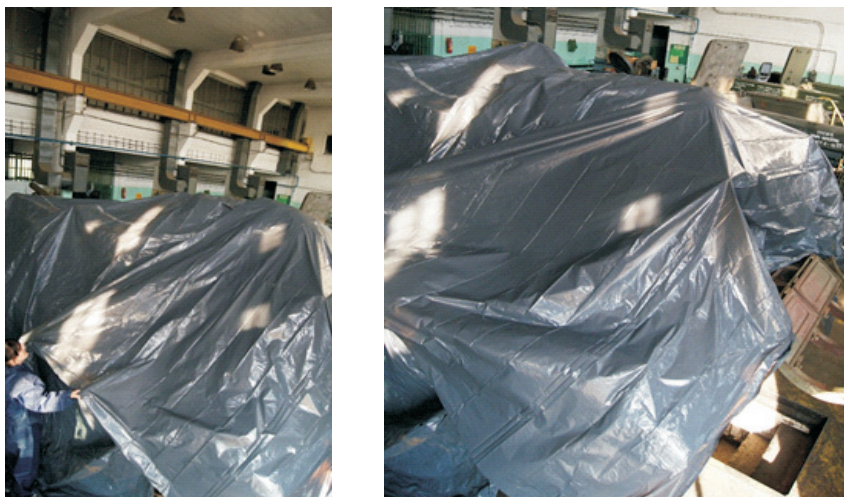
Rys. 6. Budowa komory aerozolowej nad transporterem [źródło: ze zbiorów WICHiR]
