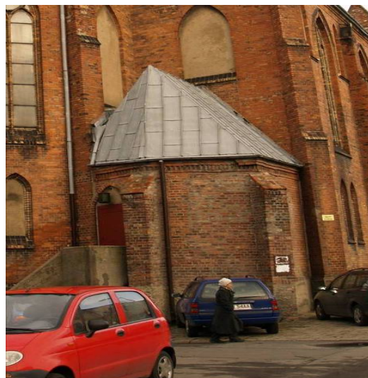
Ryc. 3. Dach nad kaplicą przy prezbiterium – w części południowej. Źródło: fot. H. Rutyna, XII.2008
