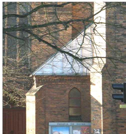
Fot. 4. Dach nad klatką schodową przyległą do wieży – w części południowej. Źródło: fot. H. Rutyna, XII.2008
