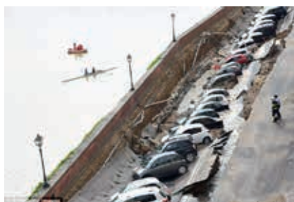
Ryc. 1. Zniszczona droga we Florencji [2]
