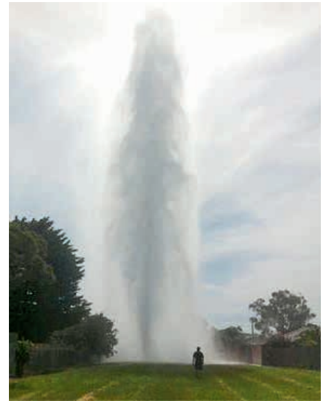
Ryc. 5. Gejzer wody spowodowany awarią zaworu [6]
