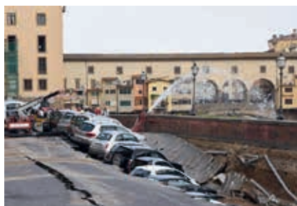
Ryc. 2. Wypompowywanie wody z zapadliska [2]
