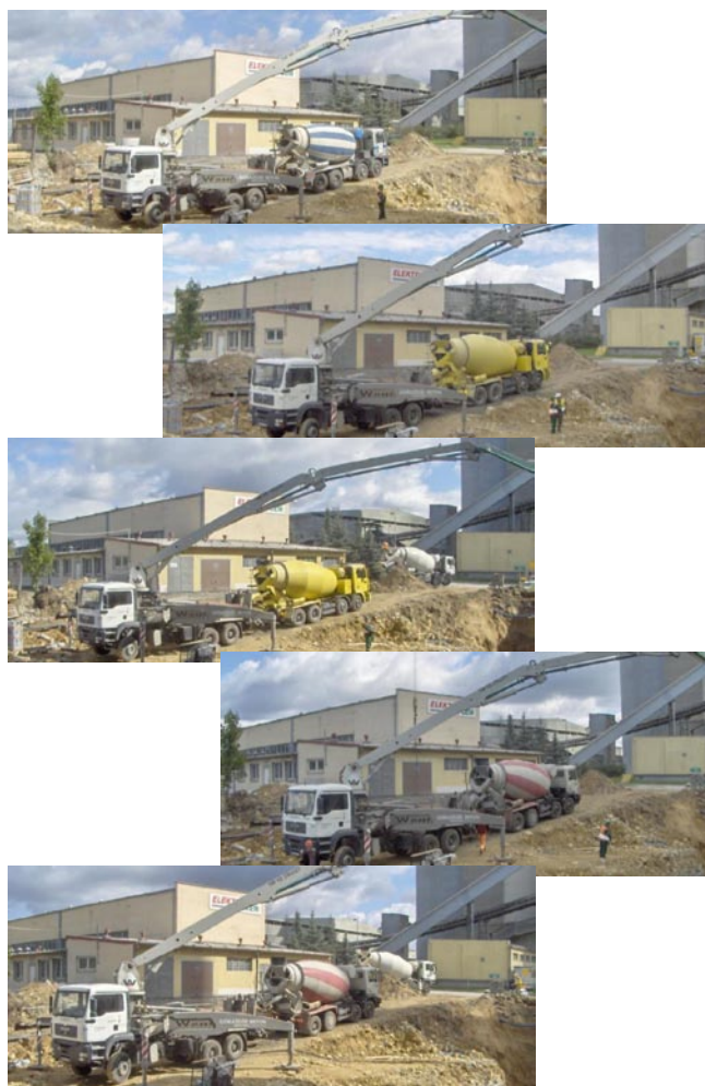
Rys. 3. Proces betonowania płyty fundamentowej; obliczenia częstotliwości przybyć mieszalników na budowę (źródło: badania własne)
