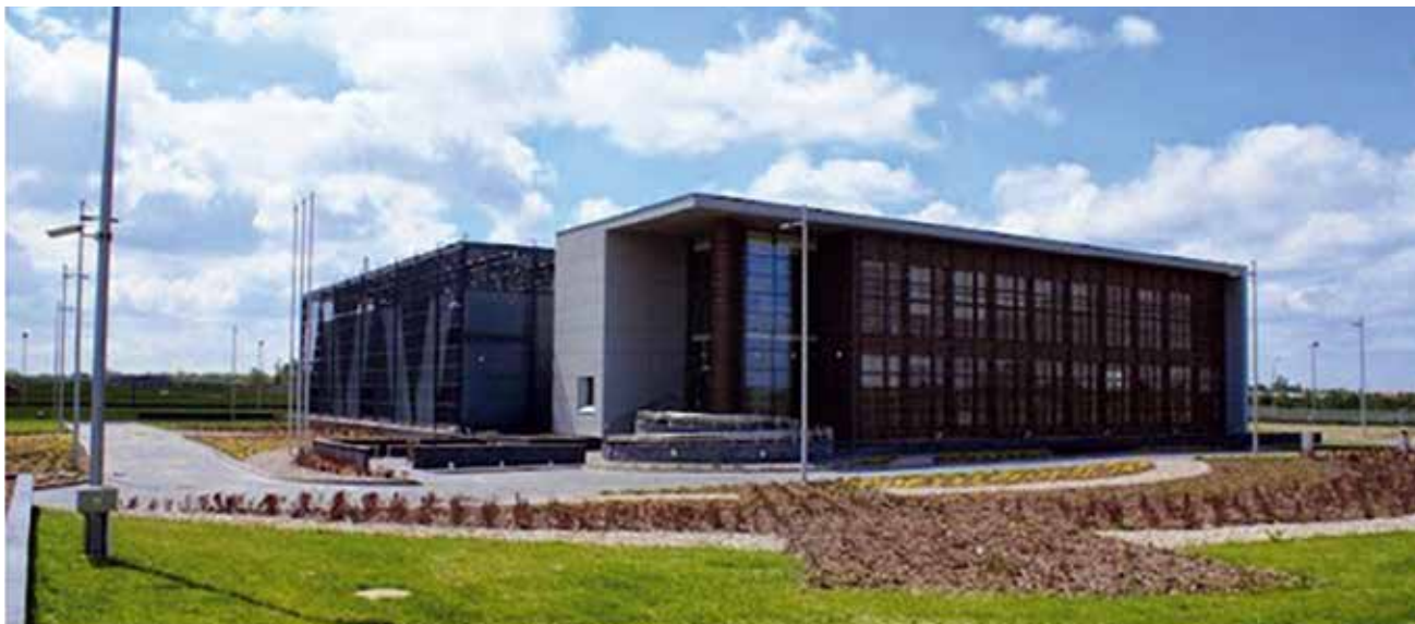
Fot. 1. Centrum przetwarzania danych Ministerstwa Finansów projektu Architekti Dawidczyk & Partnerzy; źródło archiwum autorów
