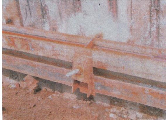
Rys. 1. Kotwa gruntowa [2]
