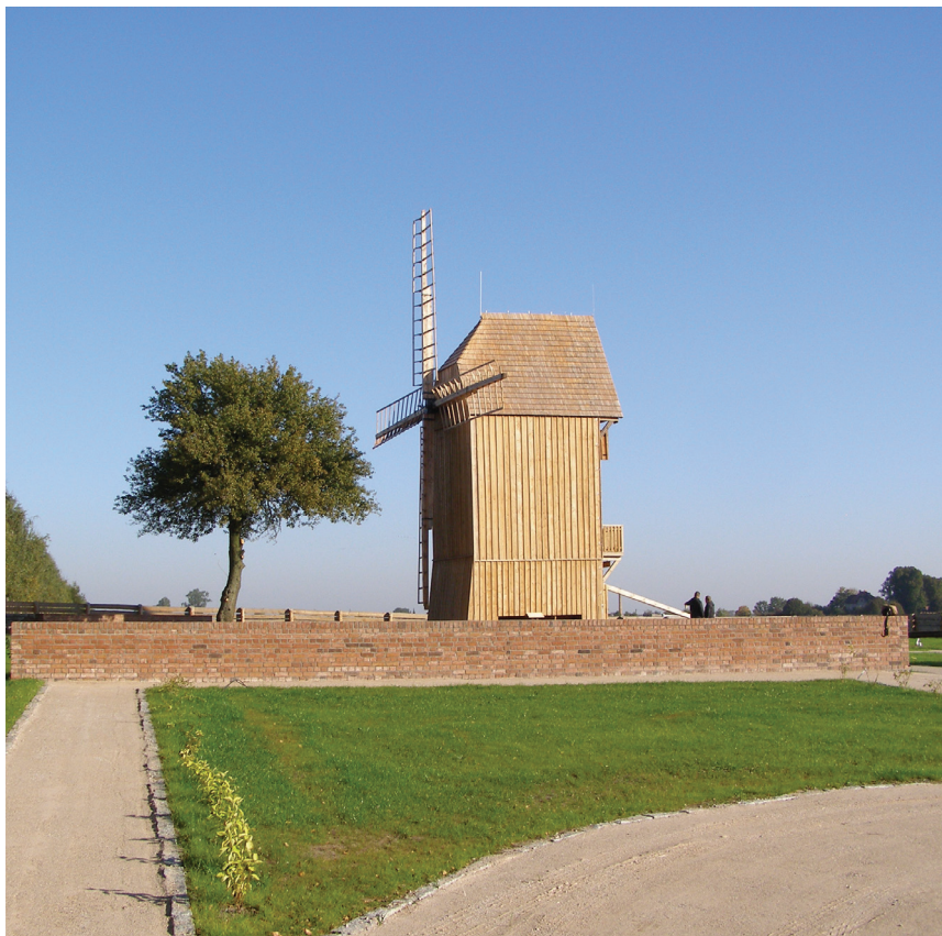
Il. 5. Wiatrak koźlak w Chrośnie po pracach remontowo-konserwatorskich: widok ogólny obiektu od strony południowej; fot. F. Tomaszewski, październik 2021 r.
