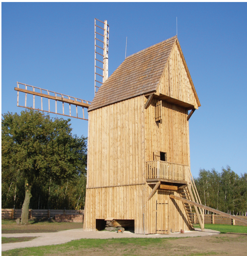
Il. 4. Wiatrak koźlak w Chrośnie po pracach remontowo-konserwatorskich: widok ogólny obiektu od strony południowo-zachodniej; fot. F. Tomaszewski, październik 2021 r.
