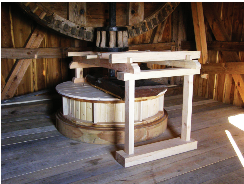
Il. 3. Wiatrak koźlak w Chrośnie: złożenie kamieni młyńskich wraz z obudową i urządzeniem zasypowym do ziarna w trakcie prac rekonstrukcyjnych; fot. F. Tomaszewski, październik 2021 r.
