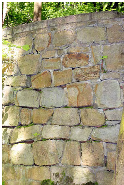
Ryc. 11. Bloki żółto-beżowej odmiany granitu. Górną krawędź muru kryją płyty wykonane z popielatego granitu biotytowego
