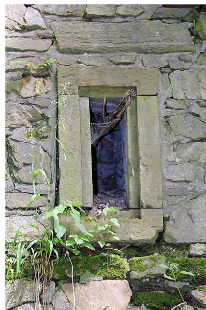
Ryc. 12. Otwór wentylacyjny obramiony piaskowcem. Nad obramieniem widoczny jest płaski blok drobnolaminowanego gnejsu
