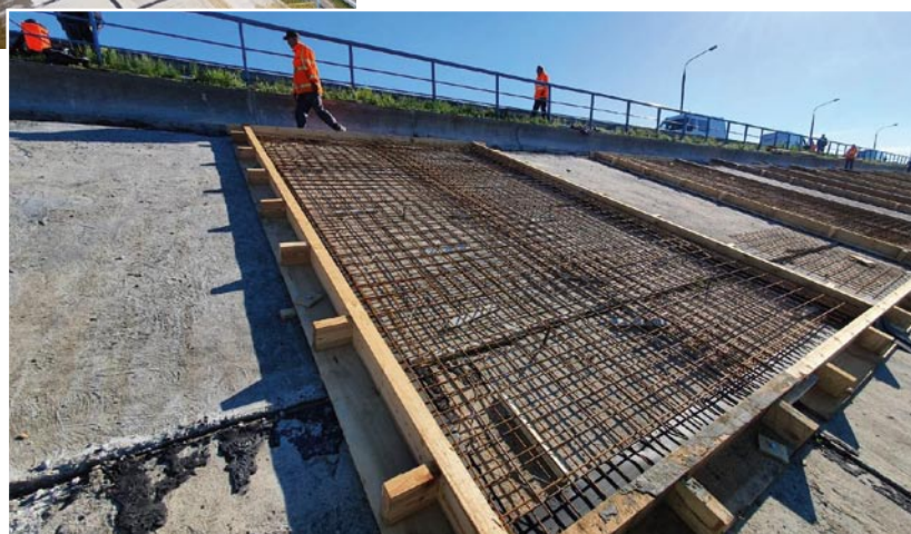
Rys. 4. Widok na zamontowane zbrojenie ▶
