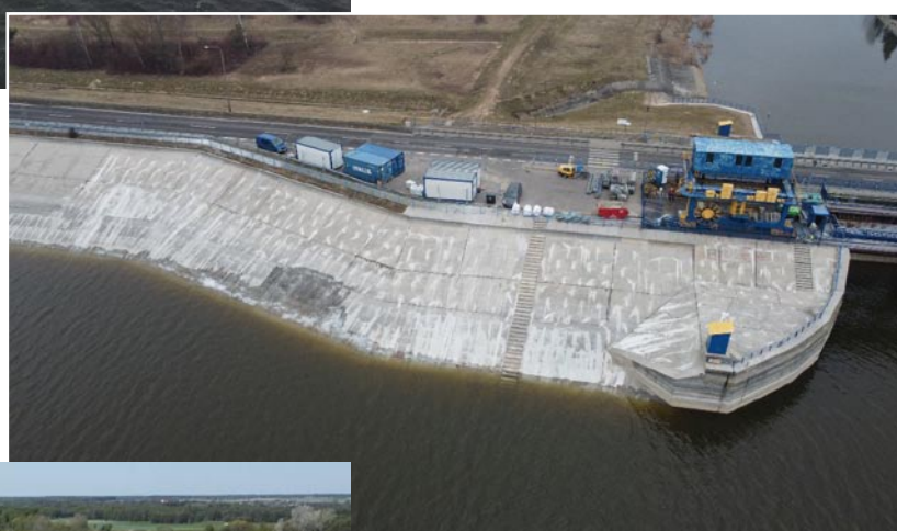
Rys. 2. Widok z drona na wykonaną iniekcję na lewym przyczółku jazu ▶
