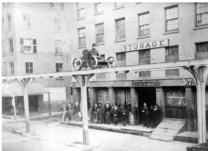
Fot. 1. Test pierwszej kolei miejskiej z napędem linowym na estakadzie. Nowy Jork, 1867
