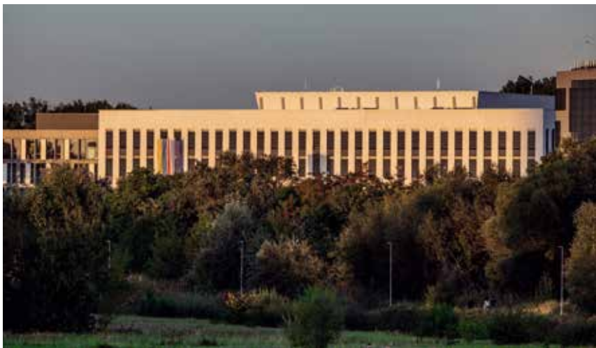
Fot. 5. Elewacja boczna od strony rzeki Warta; źródło: APPSRA
