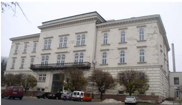
Fot. 6. Pałac Arcybiskupi we Lwowie – funkcję izolacji poziomej pełni system Mur-tronic, a od strony elewacji frontowej – również izolacji pionowej
