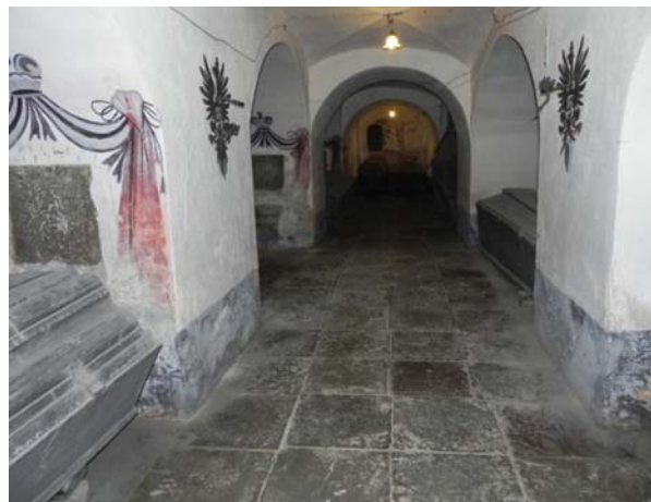
Fot. 4. Osuszone podziemia nekropolii Radziwiłłów w podziemiach kościoła pw. Bożego Ciała w Nieświeżu (fot. z 2016 r.)
