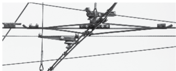
Rys. 5. Typowe tramwajowe skrzyżowanie sieciowe (Warszawa)
