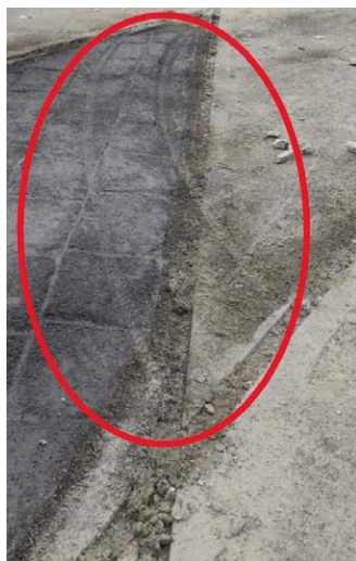
Rys. 9. Uszkodzenie nawierzchni na ul. Wyszyńskiego
