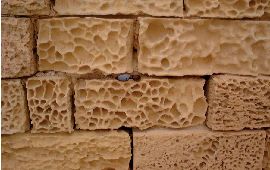
Rys. 2. Kawernowe wietrzenie solne kamienia budowlanego (dające efekt plastra miodu) na wyspie Gozo, Malta
