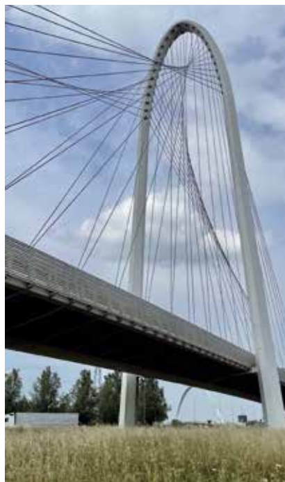
Fot. 1., 2. Wiadukty o konstrukcji podwieszanej w ciągu autostrady del Sol, Reggio Emilia, Włochy; źródło: fot. autor
