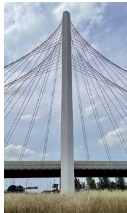
Fot. 1., 2. Wiadukty o konstrukcji podwieszanej w ciągu autostrady del Sol, Reggio Emilia, Włochy; źródło: fot. autor
