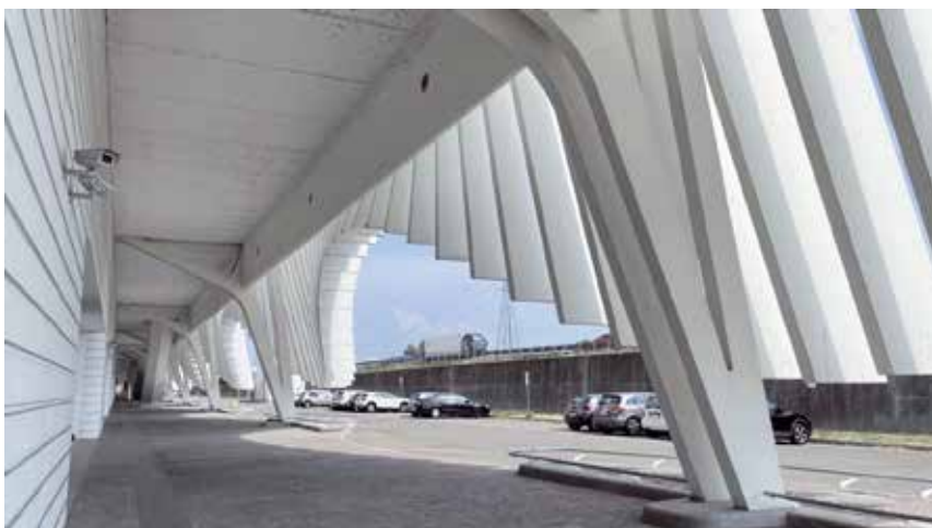
Fot. 7., 8. Stacja szybkiej kolei Mediopadana, Reggio Emilia, Włochy – widok zadaszenia wejścia głównego oraz podcień; źródło: fot. autor
