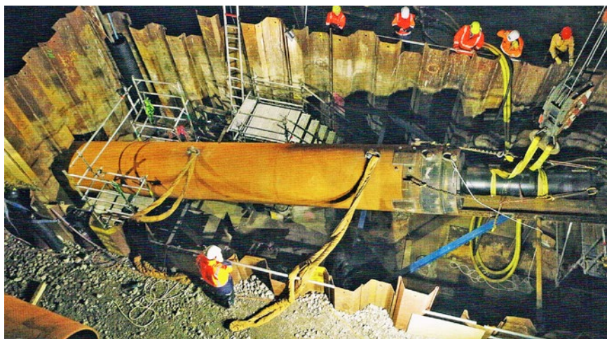
Ryc. 2. Wbijanie stalowych rur osłonowych przebijką pneumatycznym [1]
