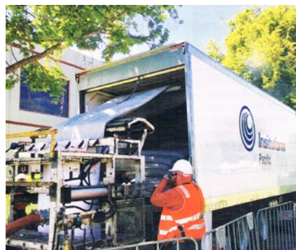
Ryc. 4. Urządzenia do renowacji w technologii CIPP w czasie pracy [1]
