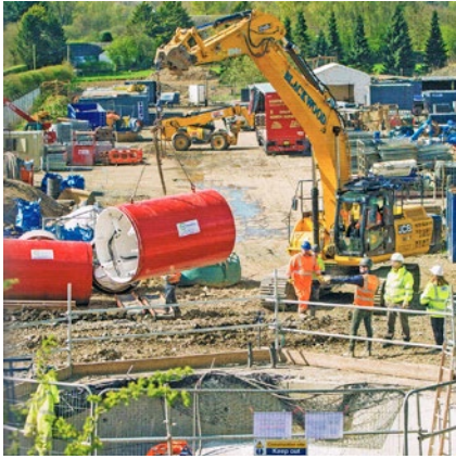
Ryc. 3. Plac budowy – widok na szyb startowy podczas opuszczania głowicy mikrotunelowej [1]
