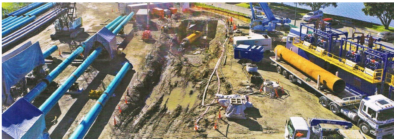
Ryc. 1. Widok na plac budowy w czasie przeciskania stalowych rur osłonowych oraz łączenia rur polietylenowych [1]
