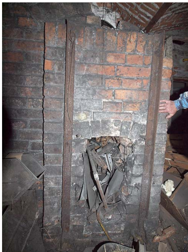
Ryc. 5. Klasztor karmelitanek bosych w Krakowie; widok wnętrza kanałów grzewczych pod kościołem oraz relikwii żeliwno-ceglanego pieca grzewczego, fot. A. Bojęś-Białasik
