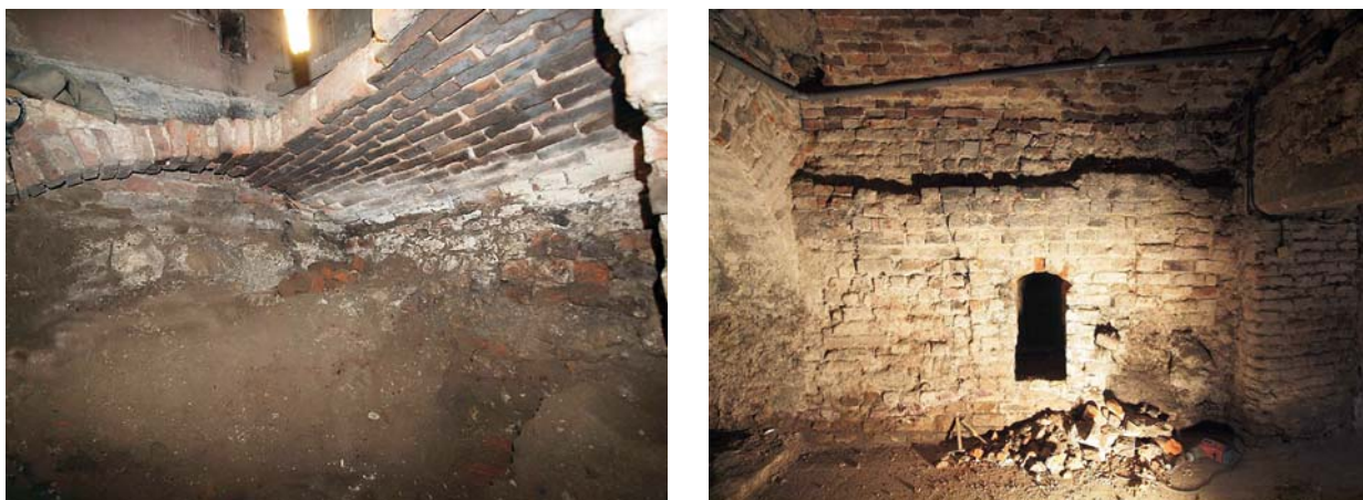
Ryc. 2. Relikt okopconego sklepienia paleniska pieca i nowy włot do komory paleniskowej, wybity po obróceniu ciągu technologicznego pieca, A. Bojęś-Białasik
