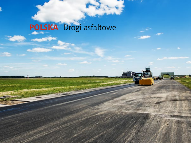
Nawierzchnia lotniska w Dęblinie, MODBIT 45/80-55 CR
