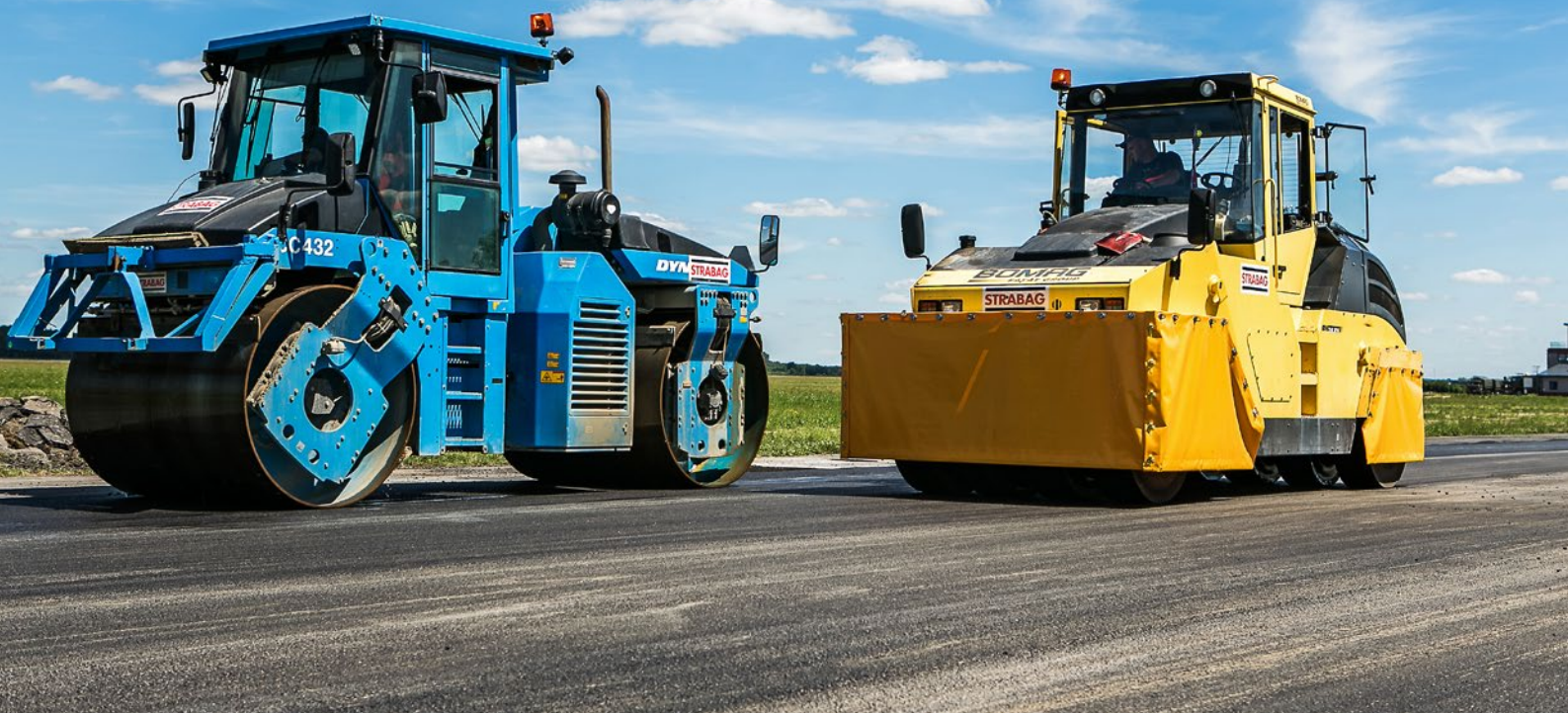
Nawierzchnia lotniska w Dęblinie, MODBIT 45/80-55 CR
