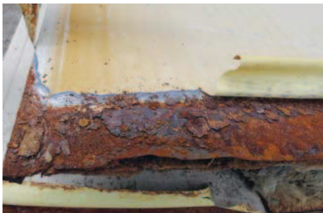
Fot. 1. Korozja chemiczna okładziny płyty warstwowej w środowisku przemysłowym
