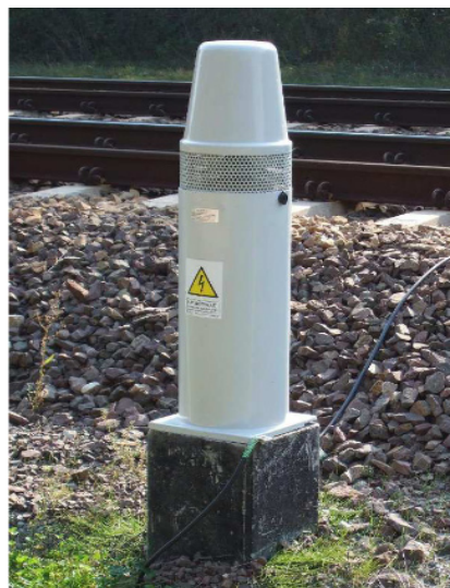
Rys. 4. Urządzenie UOZ-1 ma kształt walca o średnicy 30 cm i wysokości 110 cm [23]
