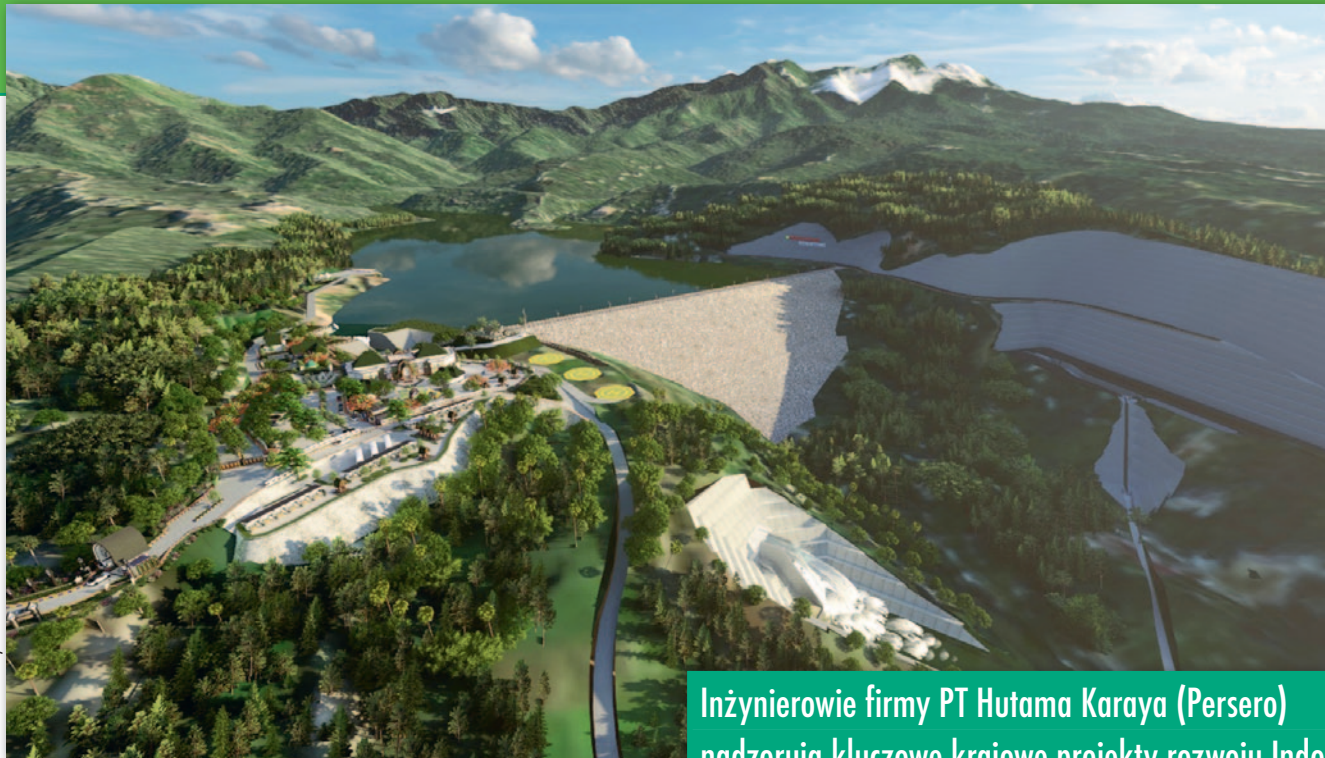
Zespół firmy PT Hutama Karya postanowił zrewolucjonizować pomiary i gromadzenie danych poprzez pełną cyfryzację procesów
