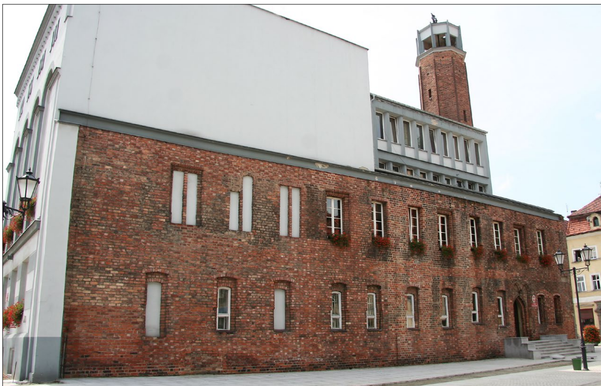
Ryc. 2. Ratusz w Koźuchowie, elewacja północna, widok od północnego wschodu, rok 2015; fot. A. Legendziewicz. Fig. 2. Koźuchów, the town hall, the north elevation seen from the northeast, 2015; photo by A. Legendziewicz.
