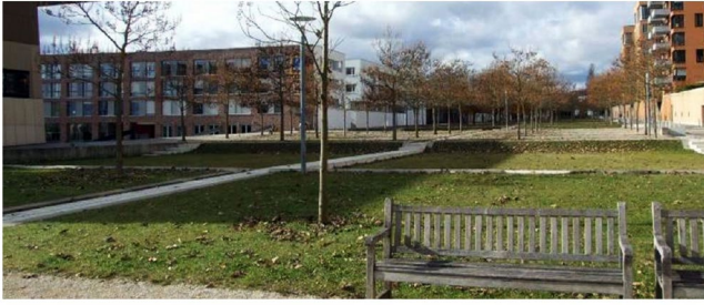
Ilustracja 20. Szereg trawiastych niecek chłonnych urozmaica ciąg spacerowy w Scharnhauser Park, Osfildern
