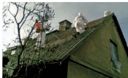
Usuwanie pokrycia dachowego w postaci płyty falistej a-c.
