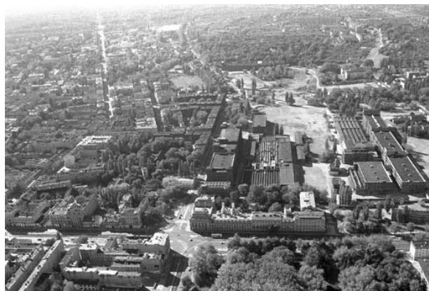
Rys.1. Widok na „Manufakturę” przed procesem rewitalizacji ( http://www.manufaktura.lodz.pl )
