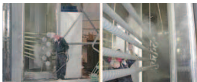
Rys. 1. Nakładanie powłok epoksydowych na stal zbrojeniową [M1]
