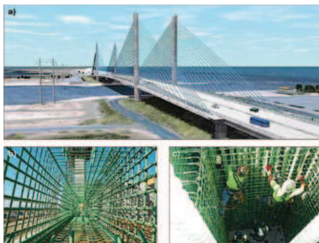
Rys. 7. Most na wlocie rzeki Indian w Sussex County, stan Delaware (USA): a) widok całego mostu, b) szkielet zbrojeniu zabezpieczony powłoką epoksydową, c) zbrojenie z powłoką w trakcie montażu; [M2]
