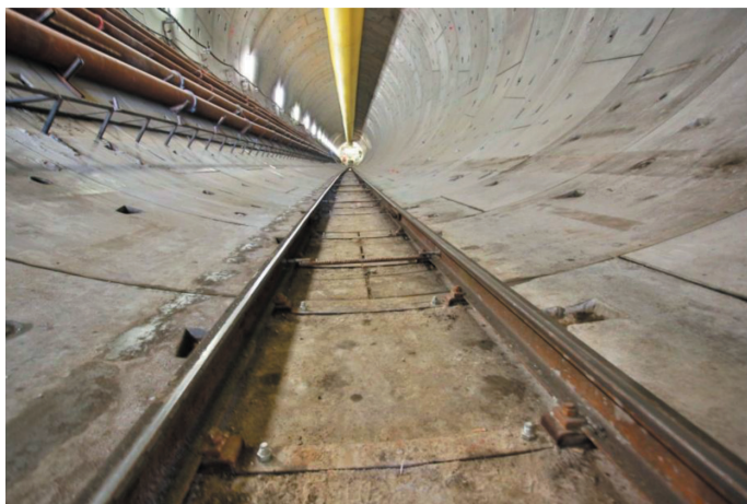
Fot. 1. Widok wnętrza tunelu podczas budowy
