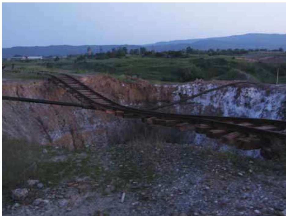
Rys. 10. Szkody górnicze nad kopalnią soli Sołotwino (Wyprawa PSGS 2008) Fig. 10. Mining damage over the Sołotwino salt mine (2008 PSGS expedition)
