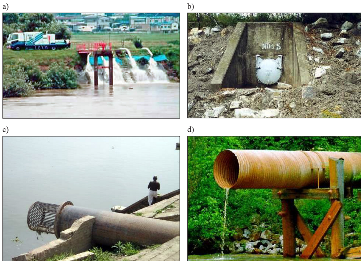
Fot. 1. a). Ruchoma przepompownia, b). wylot kolektora zrzutowego zabezpieczonego zaworem klapowym, c). zabezpieczony kratą wylot kolektora zrzutowego, d) niezabezpieczony wylot kolektora zrzutowego [www.environmenthamilton.org, www.exploit.com, www.fairfaxcounty.gov]
