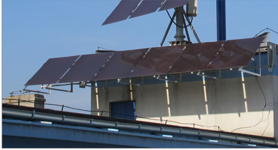
Rys. 4. Elektrownia solarna z modułami fotowoltaicznymi zainstalowanymi na nieruchomym stelażu (zdjęcia własne)
