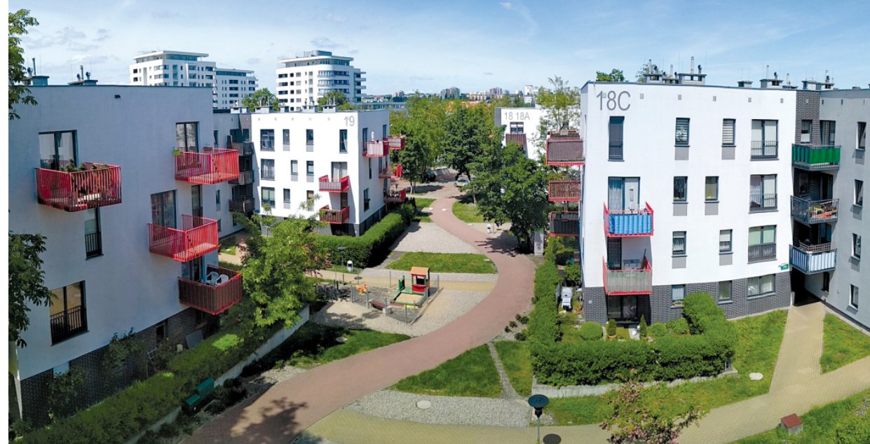
il. 1. Widok na budynek osiedla „Brzozowy zakątek” od ul. Jana Kazimierza (fot. A. Żądłowska) / A view of the „Brzozowy zakątek” housing estate from the Jana Kazimierza street (fot. A. Żądłowska)
