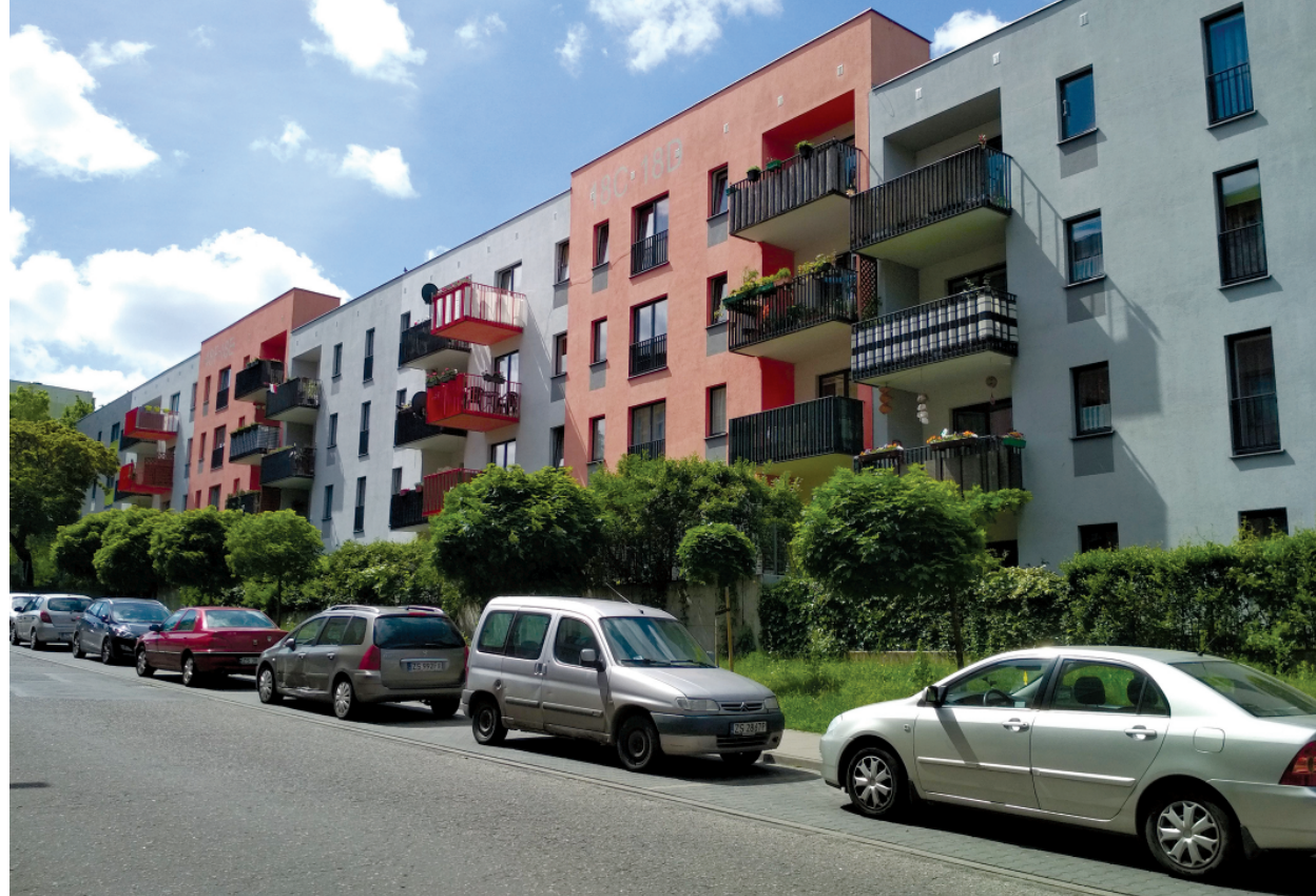
il. 3. Powszechna izolacja balkonów i loggi od strony parkingu, z odjazdem do osiedla od ul. Gontyny (fot. A. Żądlowska) / Common insulation of balconies and loggias from the parking lot, with departure to the estate from the Gontyny street (fot. A. Żądlowska)
