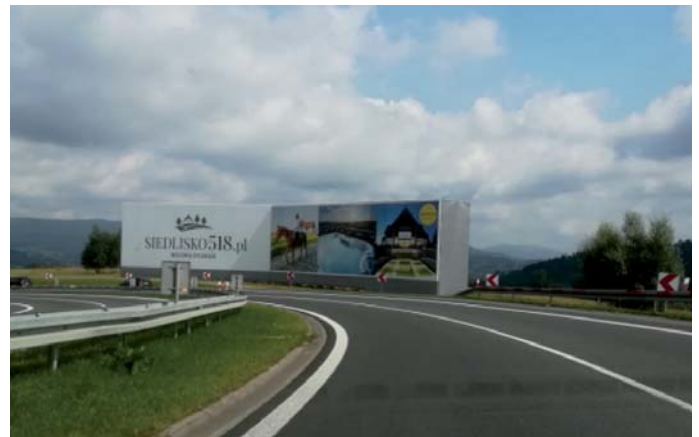
Fot. 6. Reklama zlokalizowana na łuku poziomy drogi (źródło: https://podhale24.pl/aktualnosci/artukul/58879/Bilbord_przy_zakopiance_ktory_zaslania_gory_zostal_zdemontowany.html )
