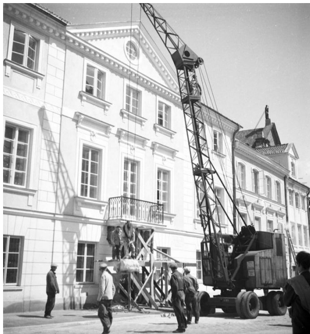
Rysunek 3. Prace wykończeniowe przy odbudowie kamienicy przy ulicy Freta 16 w Warszawie, ok. 1953 roku. Fot. Zbigniew Siemaszko, Narodowe Archiwum Cyfrowe Figure 3. Finishing works on the reconstruction of a tenement house at 16 Freta Street in Warsaw, around 1953. Photo Zbigniew Siemaszko, National Digital Archives
