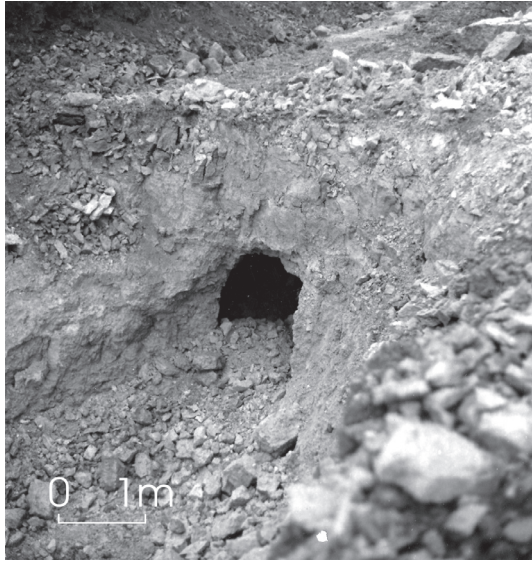
Ryc. 6. Poziomy chodnik, częściowo zagruzowany zwierzeliną skalną (fot. M. Szymaszkiewicz)
