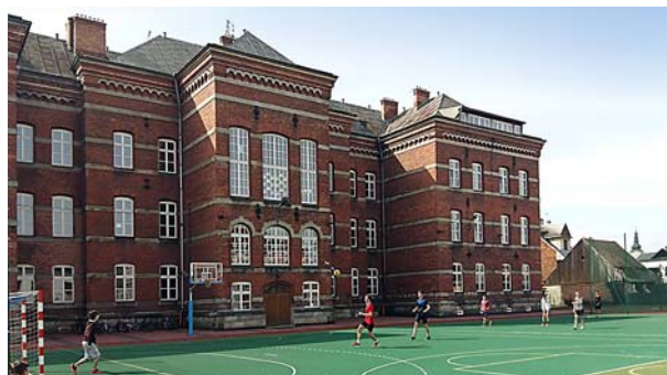
Ryc. 17. Widok na elewację tylną dawnego Gimnazjum, obecnie liceum S. Goszczyńskiego w Nowym Targu. Fot. M. Krupa, 2016
