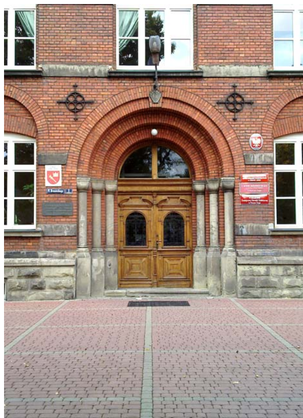
Ryc. 19. Widok na portal wejściowy do budynku dawnego Gimnazjum, obecnie liceum S. Goszczyńskiego w Nowym Targu. Fot. M. Krupa, 2016
