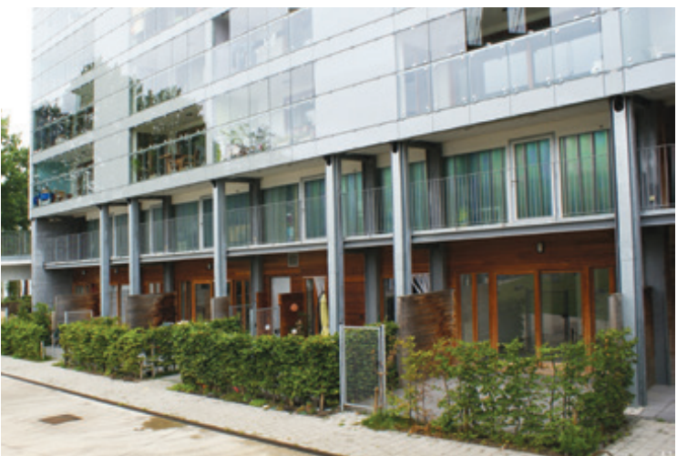
il. 3. Większe mieszkania na parterze (il. własna) / Larger flats on the ground floor (photo by author) il. 4. Biuro pracowników socjalnych (il. własna) / Social workers' office (photo by author)
