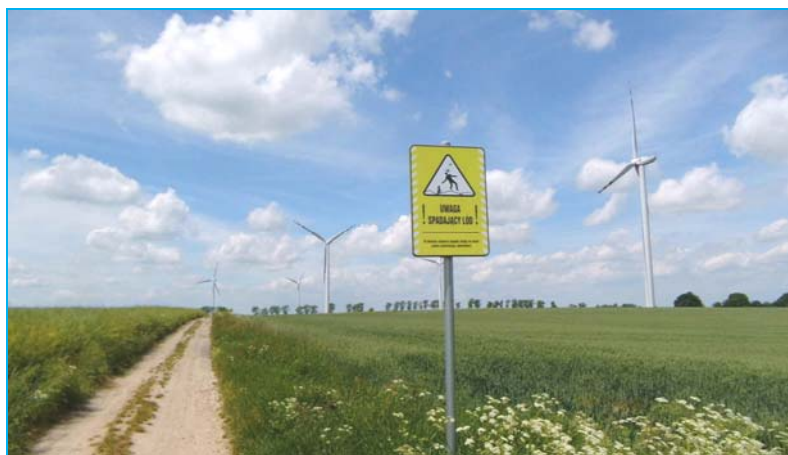
Ryc. 7. Oznaczenie przed wejściem w strefę niebezpieczną w Farmie Wiatrowej „Lipniki” wsi Lipniki. Źródło: fot: autora
