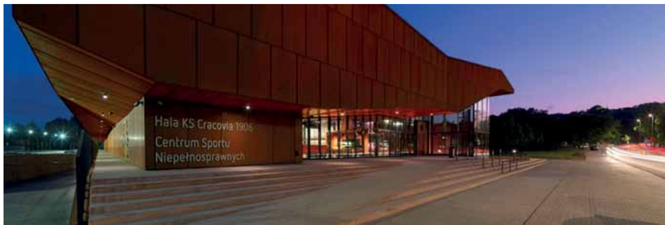
Rys. 15. Elewacje budynku wyłożone panelami z blachy corten, mocowanymi do stalowej podkonstrukcji
