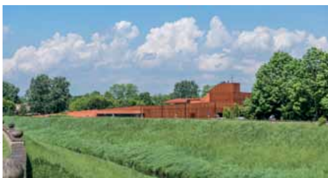
Rys. 5. Widok budynku od strony południowo-wschodniej (wzdłuż Rudawy)
