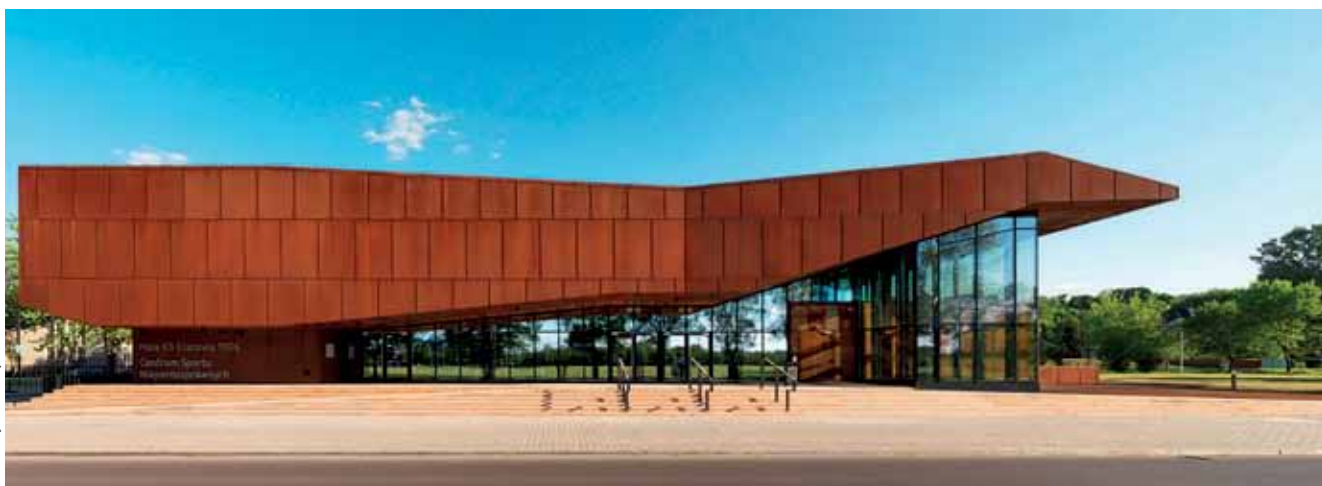
Rys. 6. Elewacja północna hali – wejście główne od strony al. Focha; parter budynku został uniesiony o ok. 1 m powyżej jezdni
