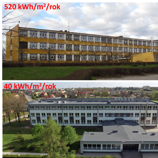
Rys. 7. Szkoła w Końskich, województwo świętokrzyskie, przed termomodernizacją i po niej
