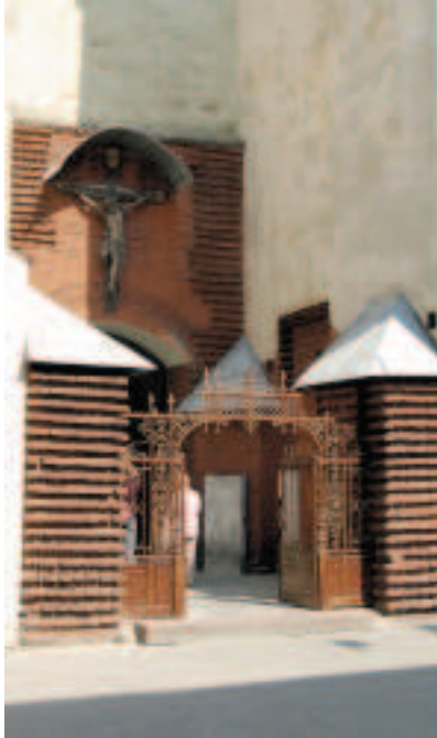
Ryc. 5. Wejście główne do katedry (rozwiązanie zastępcze) Fig. 5. Main entrance to the cathedral (substitute solution)
