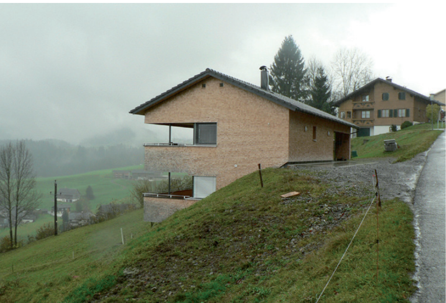
il. 6. Dom w Egg, Vorarlberg, Austria – przykład racjonalnego wykorzystania warunków topografii i nasłonecznienia (fot. aut.) / House in Egg, Vorarlberg, Austria – example of using the topographical and sunning conditions in a rational manner
