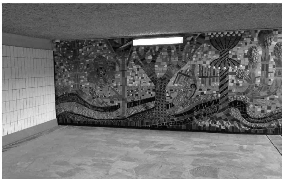
Rys. 2. Mozaika „Geneza” – praca wykonana przez artystę Tadeusza Drązkiewicza, fragment posadzki kamiennej, okładzina ściany z płytek elewacyjnych szkliwionych i sufit z ozdobnym tynkiem kraterowanym
