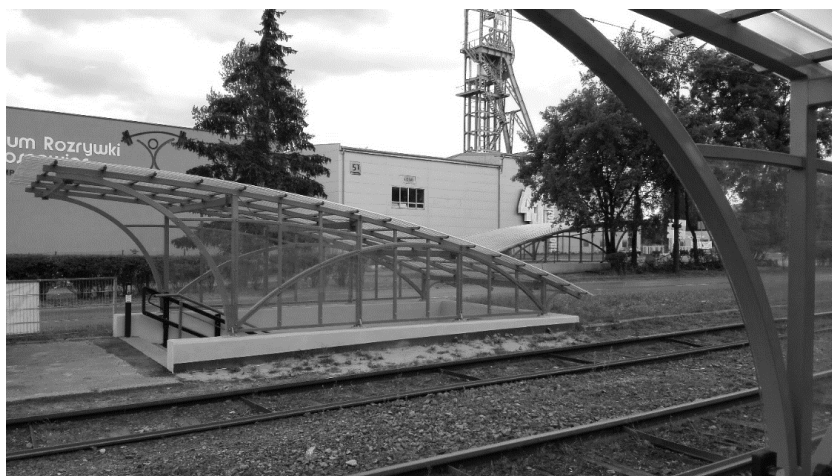
Rys. 4. Zadaszenie obiektu, w tle obiekt Centrum Rozrywki Sosnowiec, Sport Poziom 450
