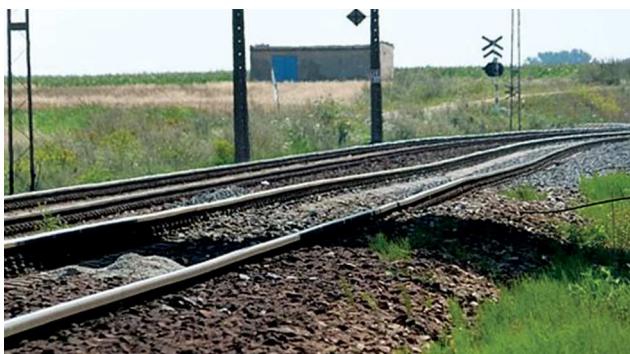
Rys. 5. Odształcenia toru pozostałe po pracy maszyny AHM 800R Fot. G. Pływaczyk
