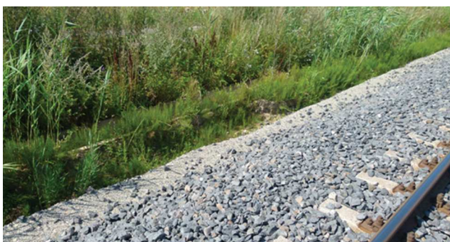
Rys. 6. Widok toru po zakończeniu robót z użyciem maszyny AHM 800R – nieścięta trawa torowiska, zarośnięte rowy Fot. G. Pływaczyk
