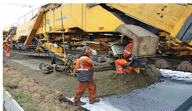
Rys. 4. Praca maszyny AHM 800R
