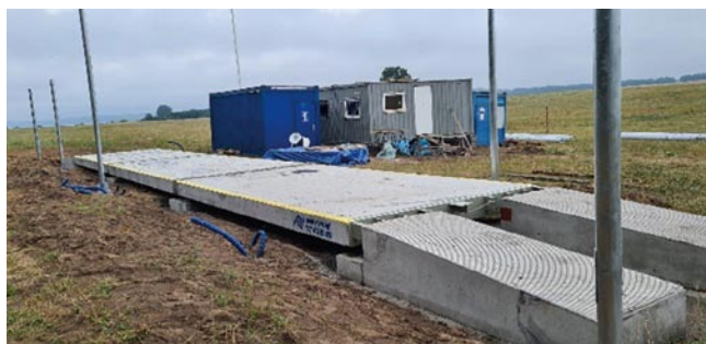
Rys. 4. Waga najazdowa 18 m; pomosty żelbetowe
