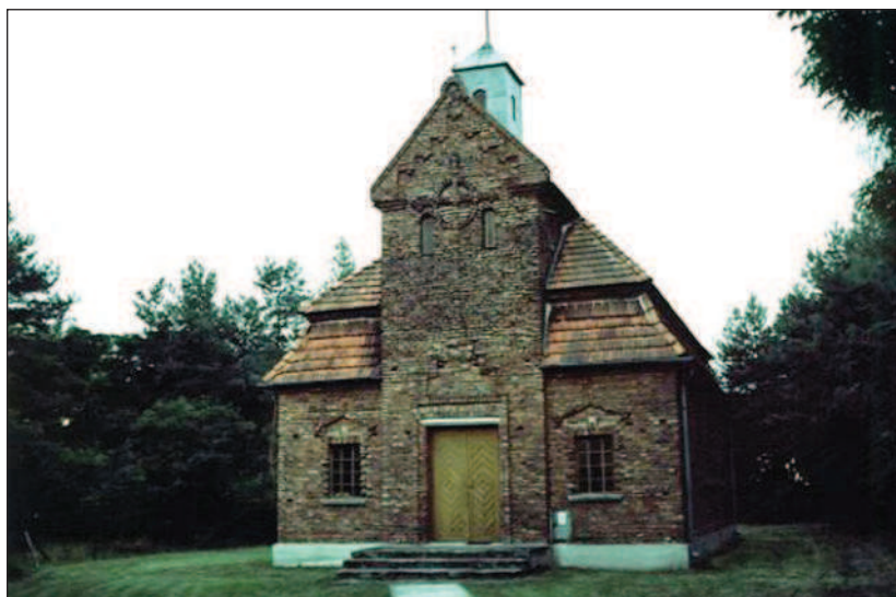
Fot. 11. Dawny kościół ewangelicki w Kolonii Przystajni, wybudowany na początku XX wieku przez osadników „ołęderskich”. Obecnie kaplica Parafii Rzymsko – Katolickiej p.w. Św. Krzyża w Brzezinach, fot. Z. Małcki, 2005r.
