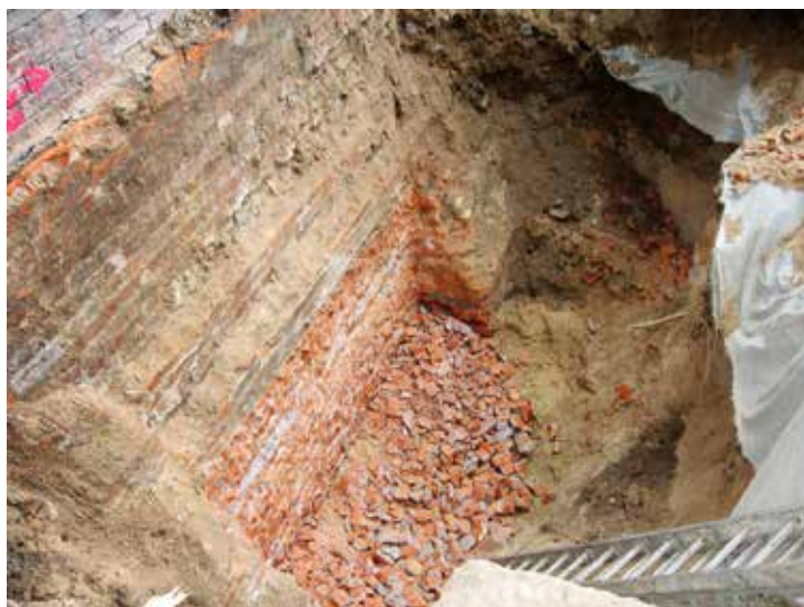
Ryc. 5. Skuty fragment odsadzki zabytkowej ściany
