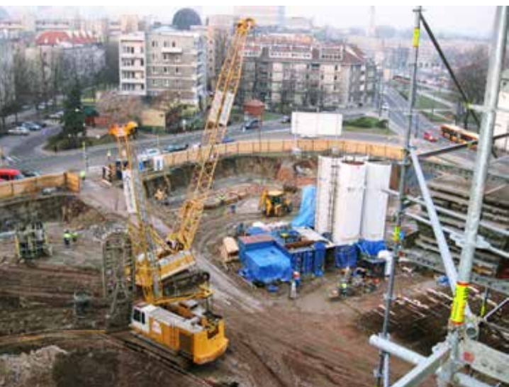
Ryc. 3. Widok węża i sprzętu do wykonania ścian i baret
