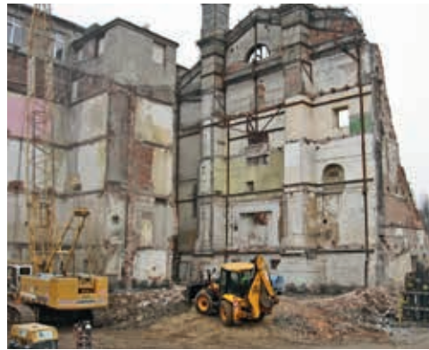
Ryc. 9. Wyburzenie i widok wzmocnionej północnej strony ściany
