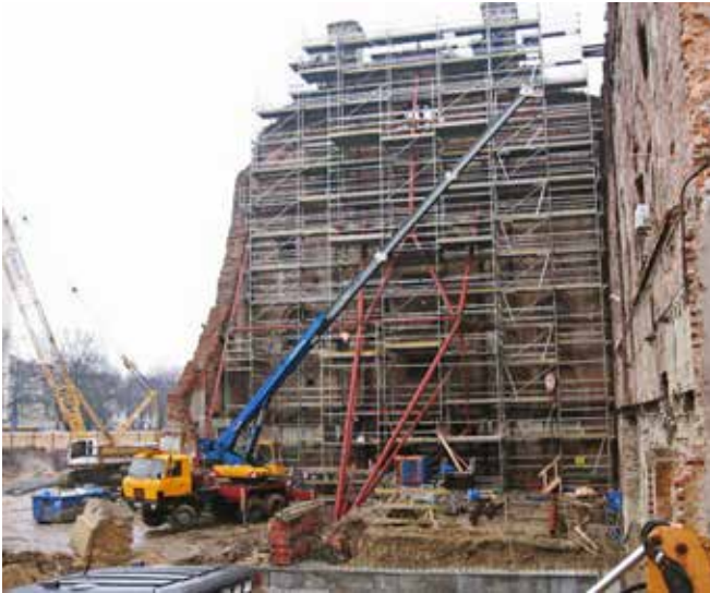
Ryc. 6. Widok zabezpieczanej ściany
