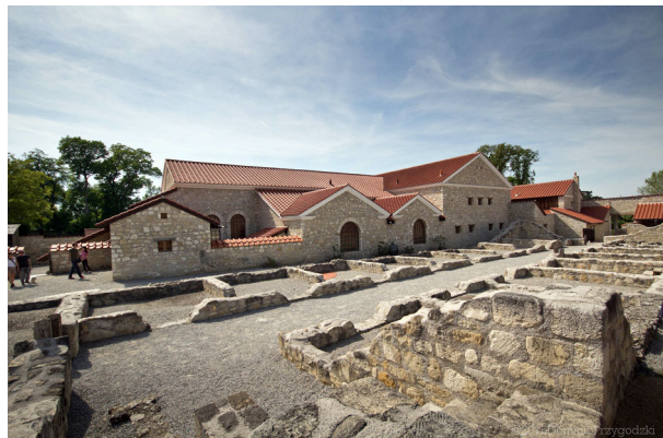
Ryc. 17–18. Park Archeologiczny w Carnuntum (kolejno): wnętrza w zrekonstruowanym budynku term publicznych wyposażone w antyczne sprzęty i instalacje
